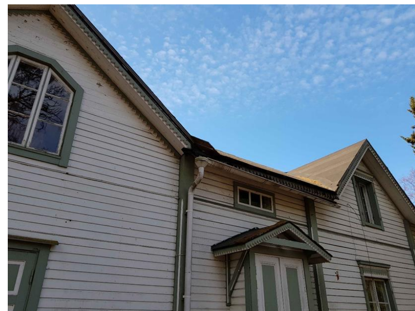
Pohjoisen puoleisella julkisivulla näkyy useaa eri levyistä verhouslaudaa. Itäpäädyssä räystään alla on vanhaa, sileäpintaista verhouslaudaa. Pääsisäänkäynnin yläpuolella on alun perin ollut katos. Sen alle on rakennettu myöhemmässä vaiheessa pieni umpikuisti.
