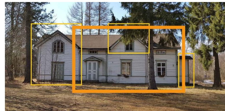
Julkisivu pohjoiseen. Vanhin, hirsirakenteinen osa on esitetty kuvassa oranssilla rajauksella. Keltaisella rajatut ovat myöhempiä laajennuksia ja muutoksia.
