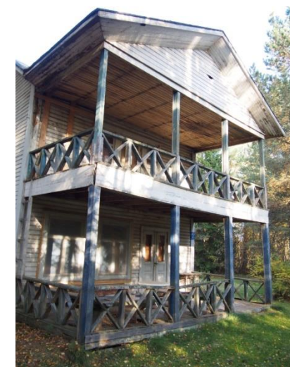
Suuri kaksikerroksinen avoveranta on esimerkiksi osoitteessa Hietasaarentie 32 sijaitsevassa huvilarakennuksessa. Saman kaltainen suuri veranta on saattanut olla myös Lundmanin huvilan itäpäädyssä. (Kuvat Miettinen 2015, 39-41.)
