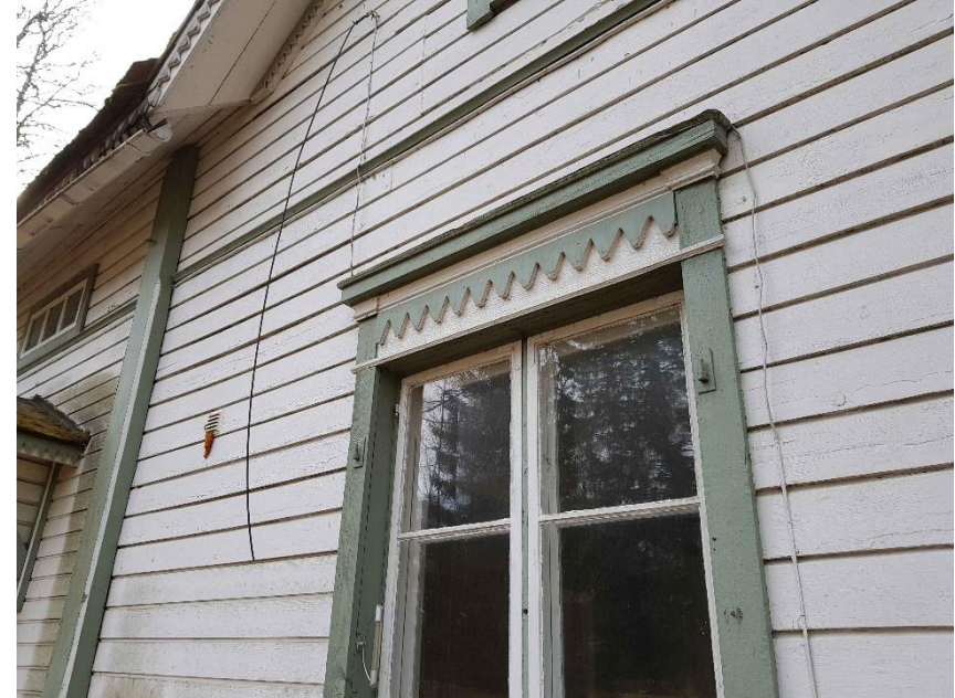
Rakennukselle luonteenomainen yksityiskohta ovat sahalaitakuvioiset koristelilat.
