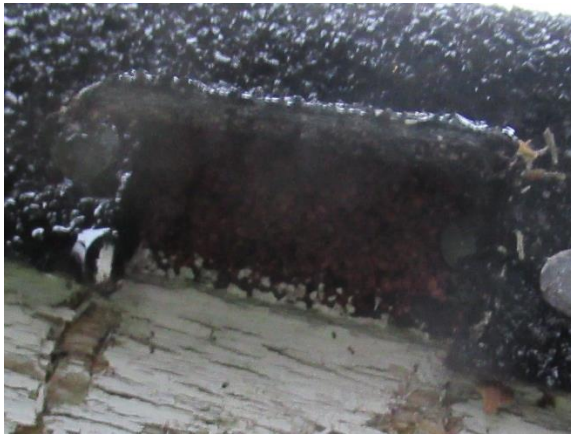
Näyte 8. Saunarakennuksen vesikaton alempi bitumikermi (punainen sirote).
