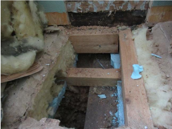
Rakenneavauksen (AP-RA-2) toisella reunalla olevan lankun alla maanpinta viettää laakealle kuopalle. Lankussa havaittiin tummentumaa.
