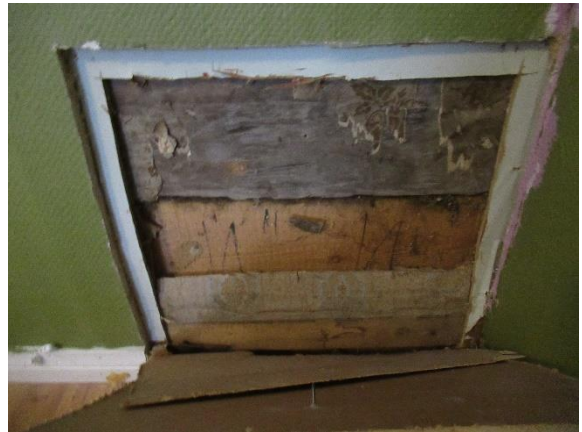
Ulkoseinän rakenneavaus (US-RA-1).
