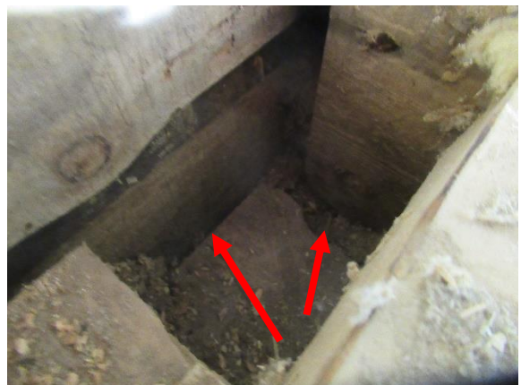
Tuulensuojalaudoituksen ja hirsirungon välissä on rako, josta on yhteys maaperään (AP-RA-1).
