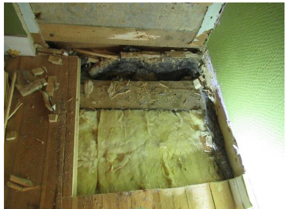
Villaeriste on suoraan lattialaudoituksen alapuolella kantavien lattiapalkkien välissä. Villaeristeen päällä ei ole ilman- tai höyrnsulkua.
