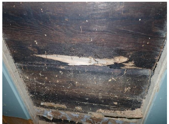
Tummentuma on ainoastaan vaakalaudoituksen pinnassa. Pinnasta on vuoltu pala pois (US-RA-3).
