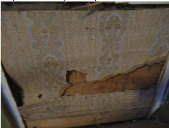
Rakenneavauksessa (US-RA-1) tapettipintainen pahvi hirren ja levyjenpintojen välissä.
