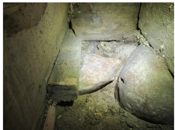
Hirsirungon ja luonnonkiviperustusten välissä ei ole erotuskaistaa (US-RA-1).
