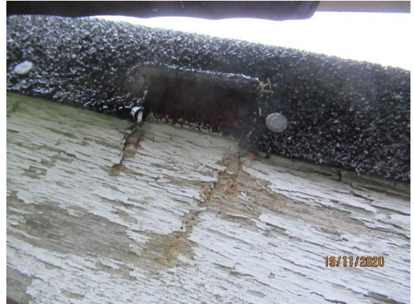
Näyte 7. Saunarakennuksen vesikaton ylempi bitumikermi (musta sirote).
