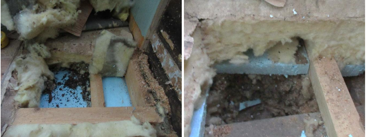
Lattiamaton ja lastulevyn alla on käytetty villaeristettä. Villaeristeen alla on XPS-eriste. (AP-RA-2).
