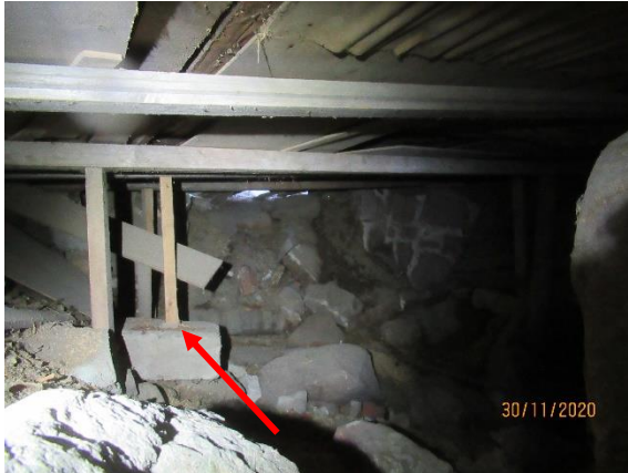
Alapohjan tukirakenteiden ja betonin välissä ei havaittu erotuskaistaa.
