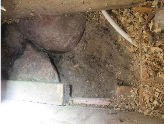
Tuulensuojalautoitus maapohjaa vasten avauskohdalla (AP-RA-1).
