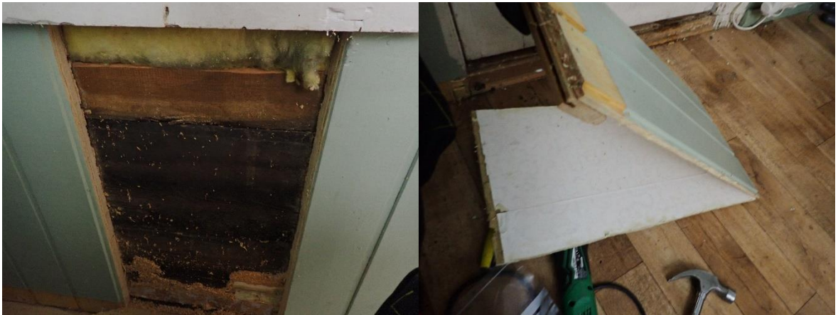
Avauksesta US-RA-3 sis. havaittu rakenne. Sisäpuolella on puupanelointi.
