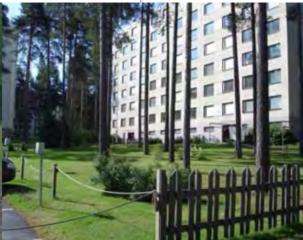
KUVA 30. Pihaja on aidattu Nuolihaukantiellä
