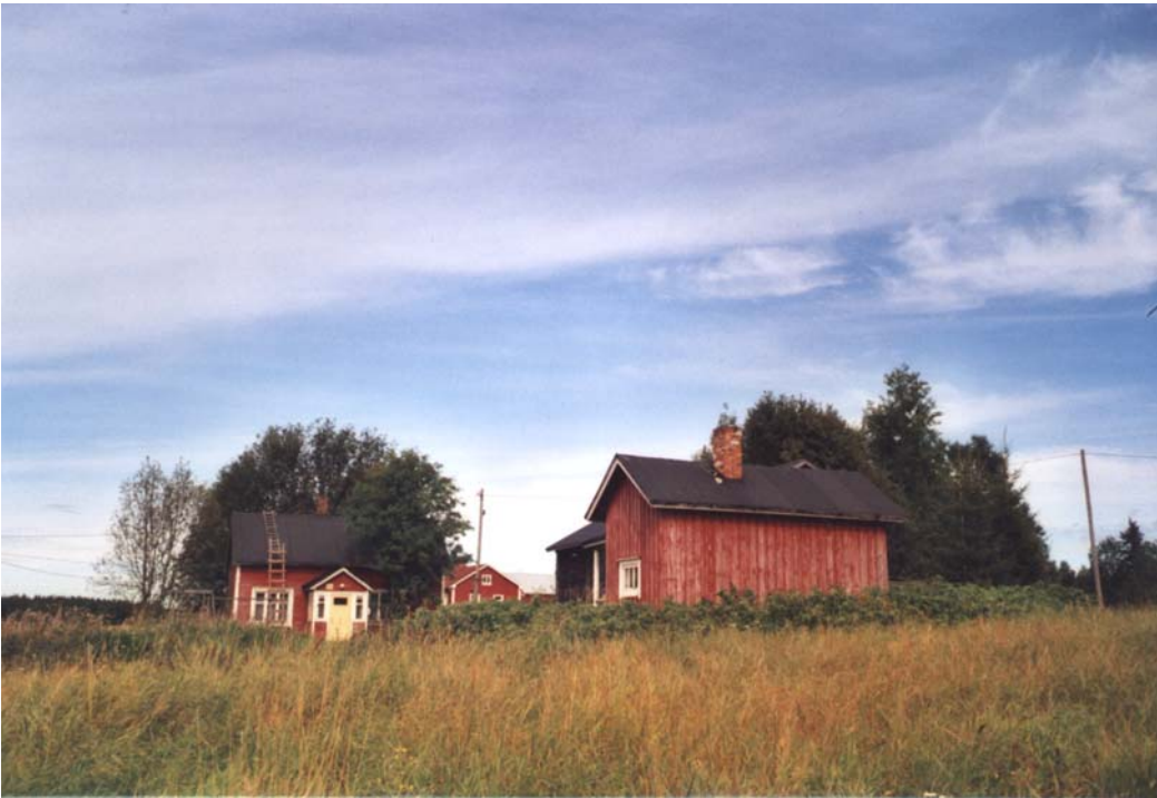
Kuva 24. Viehättävä tyhjillään oleva rakennusryhmä tulisi kunnostaa ja ottaa käyttöön ennen kuin rakennukset rapistuvat korjauskelvottomiksi maisemahäiriöksi.
