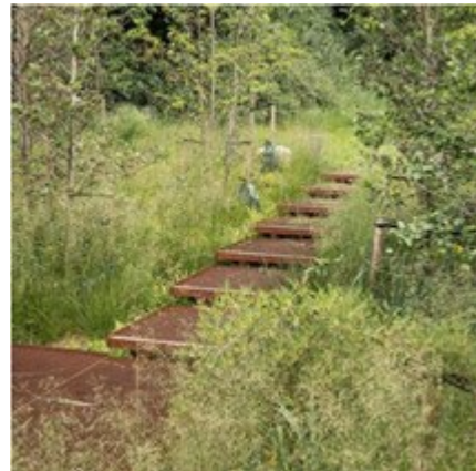
Esimerkki ritilärakenteella toteutetusta reitistä kasvillisuuden säästämiseksi. https://www.gneegarden.com/product/corten-steel-stair-grille-style-steps/
