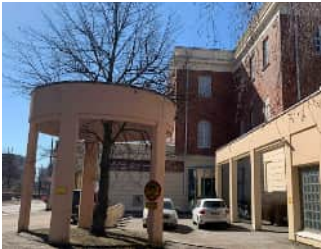
Kuva 3. Lehmus kehikossaan taidemuseon itäkulmassa. Puu eikä kehys pääse yhdessä oikeuksiinsa. Rakennuksen vierellä on pensasistutus sekä henkilökunnan pysäköintipaikkoja. Autot eivät sovi arvokkaan rakennuksen julkisivun välittömään läheisyyteen.
