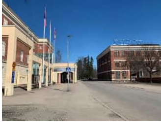
Kuva 1. Näkymä taidemuseosta Kasarmintien varrella. Pylväikkö ulottuu lähes ajoradan reunaan ja ihmiset kulkevat usein katoksen alta.
