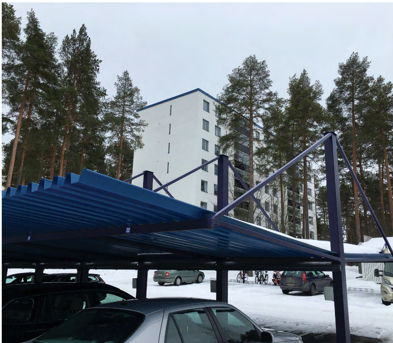
Hiioharjun kahta tehosteväriä on käytetty päärakennuksen lisäksi autokatoksessa, jonka siipimäinen katto maalattiin vuoden 2018 saneerauksessa molemminpuolin. Maalausta varten teräksiset poimulevyt vietiin erikoismaalaamoon Tornioon. (Kuva: Raija Kristo 2022)
