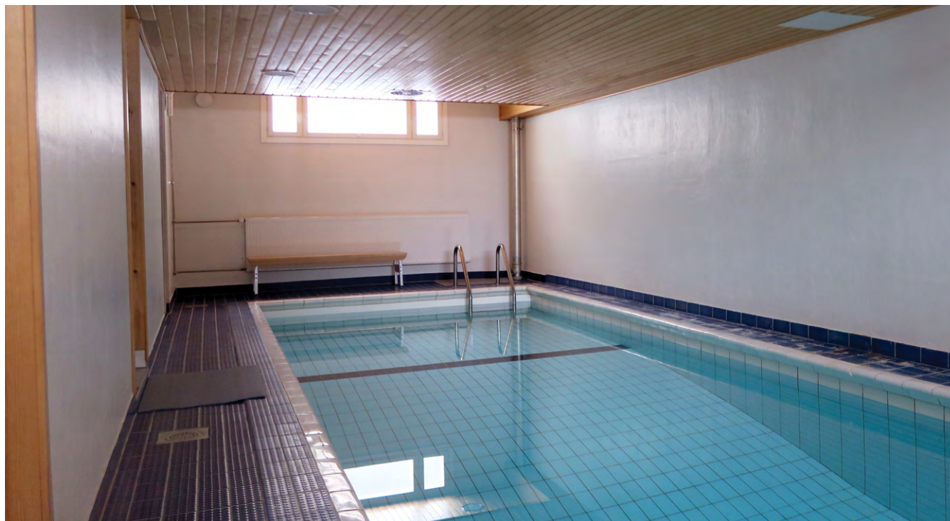
Uimahuone on säilyttänyt pääosin alkuperäisen ilmeensä. Lattialaatoitus on Pukkilan sinistä näppylälaattaa, ovet mäntyä ja katossa puupanelointi. Ikkunakarmit olivat alunperin siniset myös sisälle päin. Uima-altaan mitat ovat n. 9 x 3 m ja tilavuus n. 40 m 3 . (Kuva: Juuso Piippo 2022)
