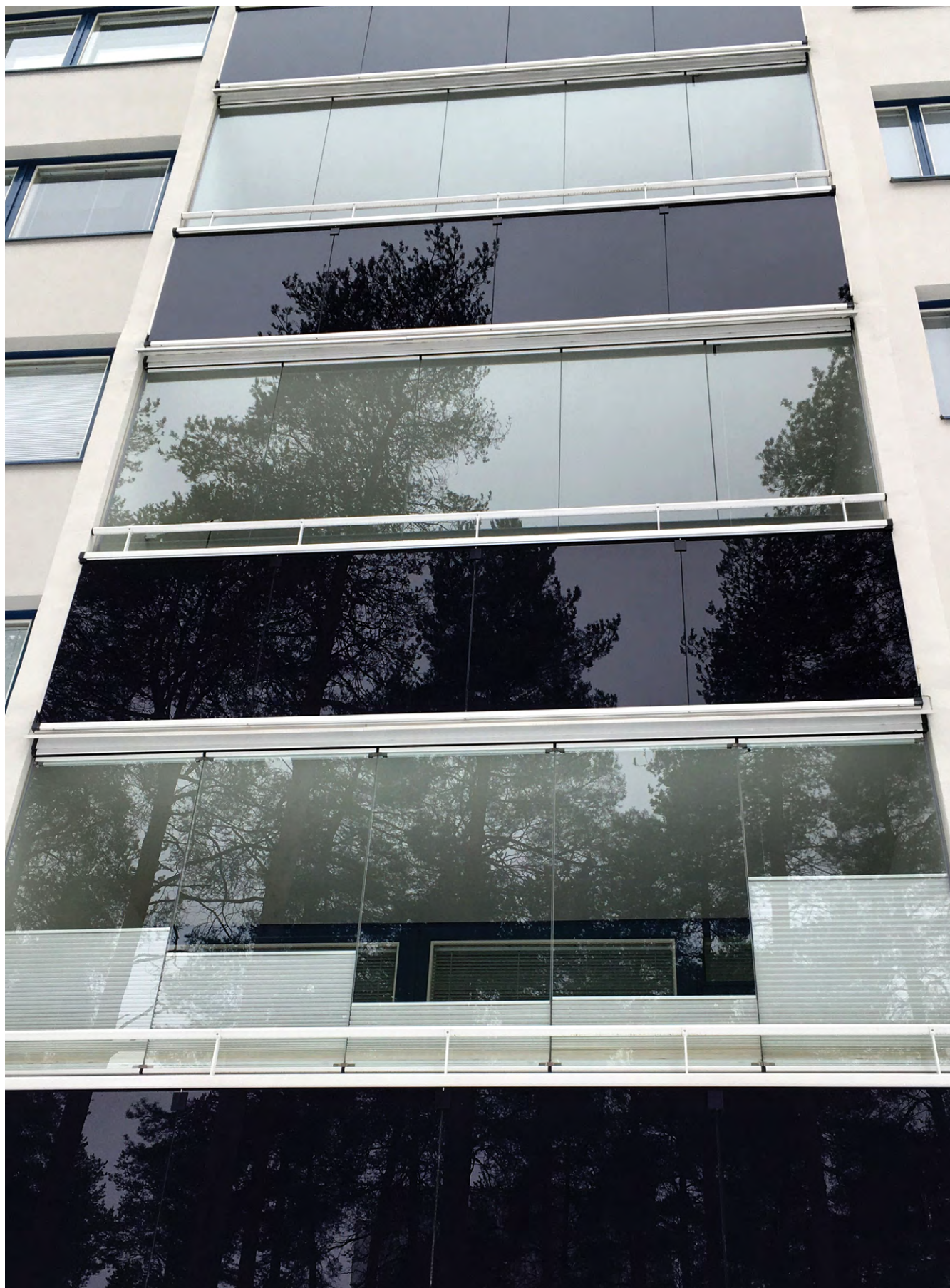
Kolmioiden parveketorni. Parvekekaiteiden väri on saatu aikaan laminoimalla värikalvoja päällekkäin lasien väliin. Koska väri muodostuu eri värien yhteisvaikutuksesta, se elää luonnonvalon määrän mukaan. Pilvisellä säällä se näyttää lähes mustalta, auringonvalossa tumman purppuransiniseltä, jopa lilalta. Sisälle päin parvekekaide on valkoinen. (Kuva: Raija Kristo 2022)
