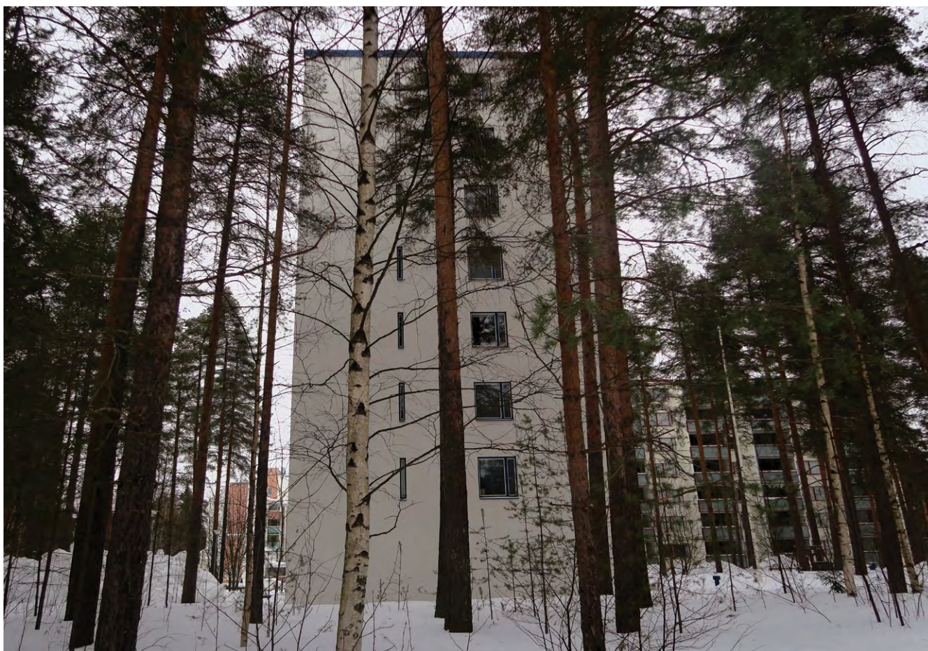
Talon länsipäätyä Merikotkanpuistosta kuvattuna. Neliöt sijaitsevat länsipäädyssä ja pohjakerroksessa on sauna- ja uima-allasosasto. Kellarissa on väestönsuoja. (Kuva: Juuso Piippo 2022)
