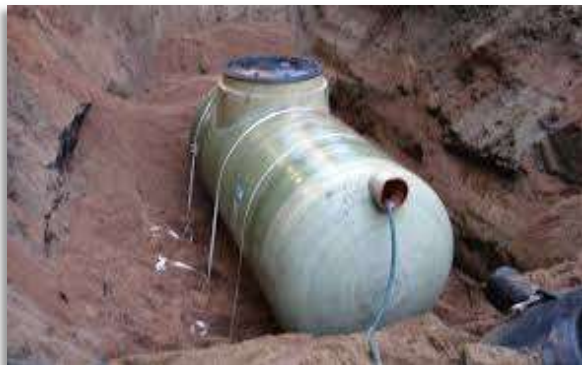
Kuva 7. Öljynerotin (Hiekan- ja lietteenerottimen, öljynerottimen ja sulkuventtiilikaivon asennus, 2012).
