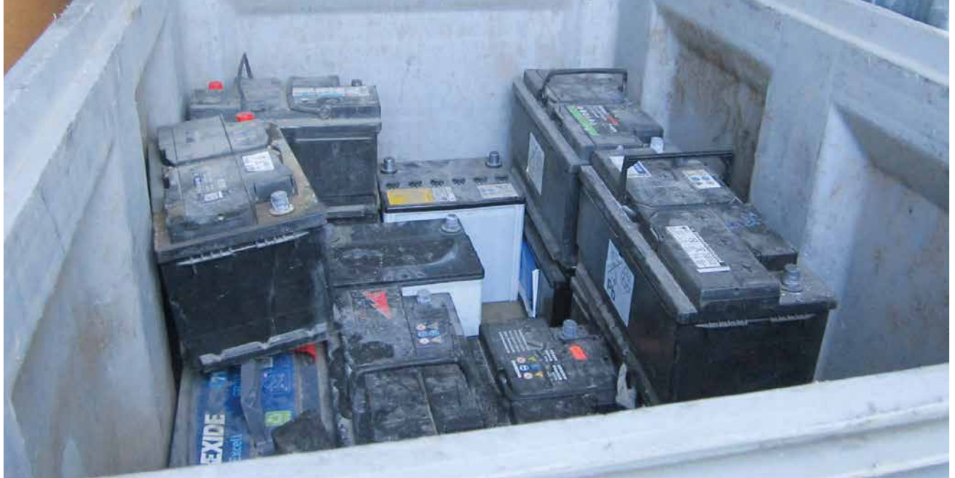
Kuva 7. Lukittavassa kontissa olevaan akkulaatikoon varastoituja akkuja.
